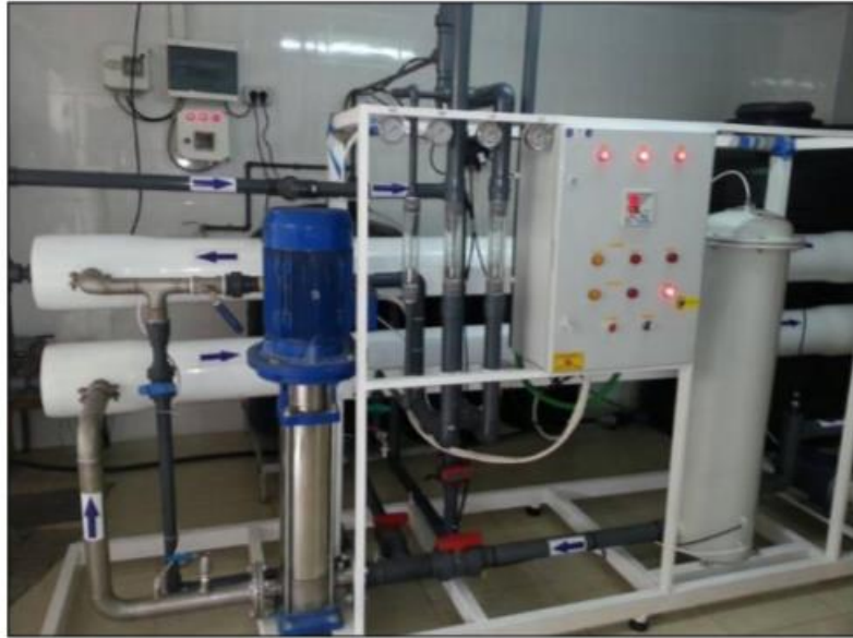
شكل رقم (4.1) طريقة التناضح العكسي لإحدى محطات التحلية في قطاع غزة المصدر: شقليه، 2013، ص30
